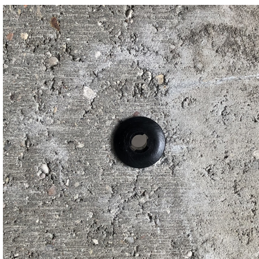
Rys. 6. Wcisnąć grzybek anteny (Rys. 1).
